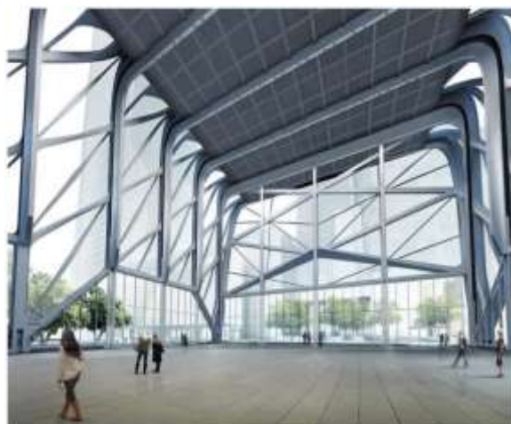
Рис. 2. Культурный центр The Shed, Нью-Йорк, США
